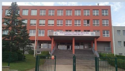
SOŠGS (budova A)
